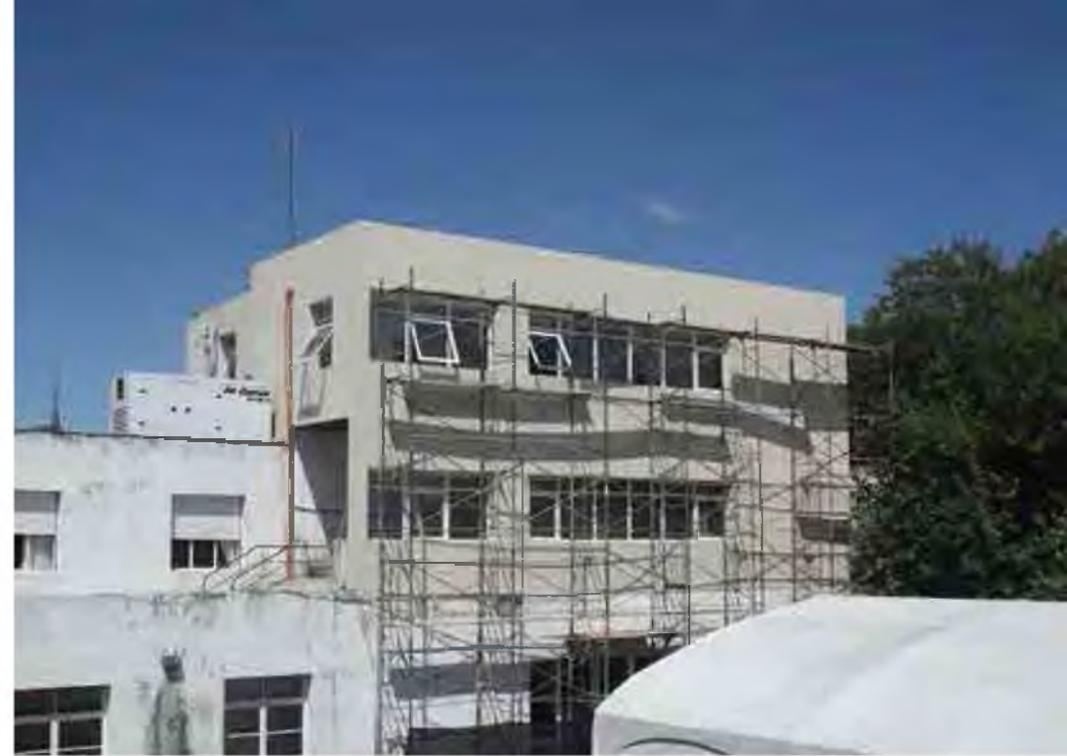
Restauración de la fachada Norte del edificio principal, sus muros con terminaciones símil piedra y sus carpinterías. Obras de completamiento del bloque central que incorpora un volumen en el primero y segundo piso destinado a usos administrativos para el cual se aplica el mismo lenguaje arquitectónico que se adopta en todas las nuevas obras desarrollar.
